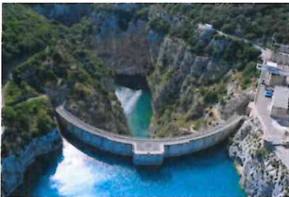
Barrage de Sainte-Croix
