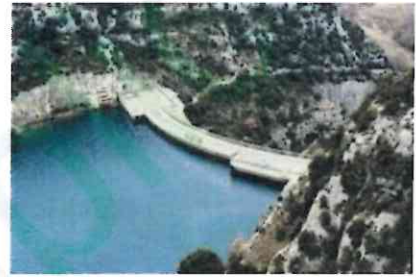
Barrage de Quinson
